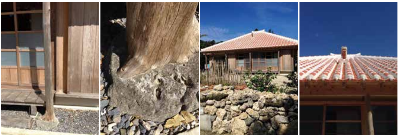
写真2 造礁サンゴを用いた建築物や漆喰
