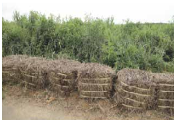
写真7 サトウキビの葉を活用した堤(WWF ジャパン提供)
