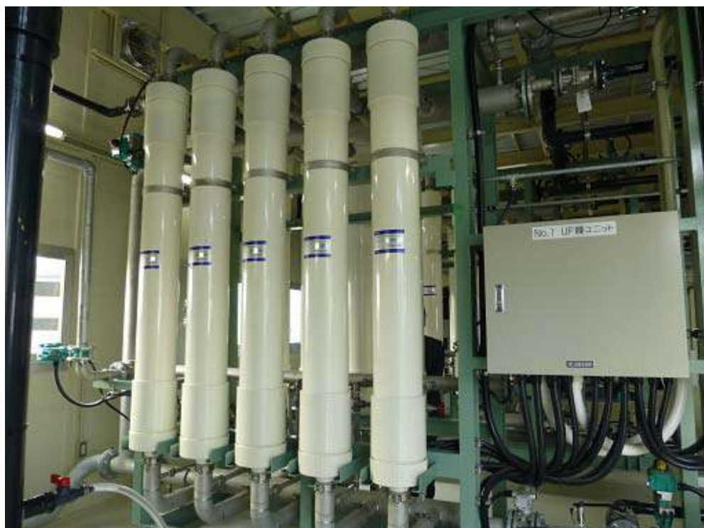
図 2-5 UF 膜ろ過装置(実証施設)の外観
