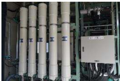
左：UF 膜ユニットの様子 中：UV 消毒機器の様子 右：プラント内はすべて電気で制御される 出所）筆者撮影
