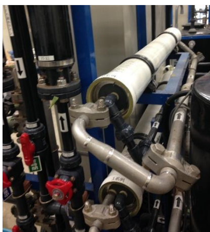
図 3.4 沖縄県内 A 下水処理場に設置された RO 膜装置
