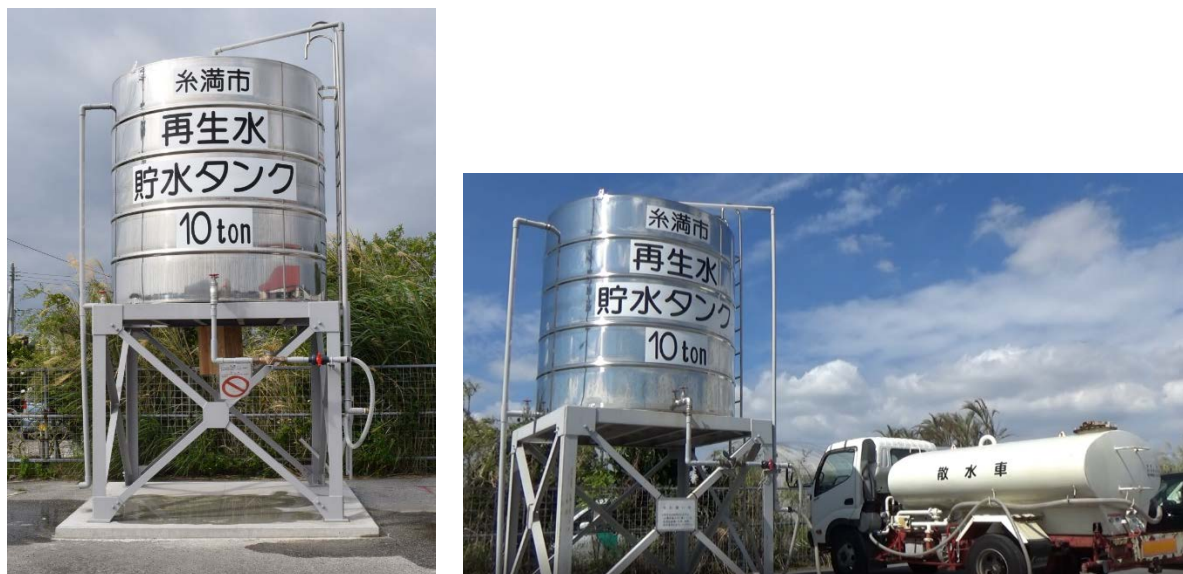
図 1-2 再生水の貯水タンク
