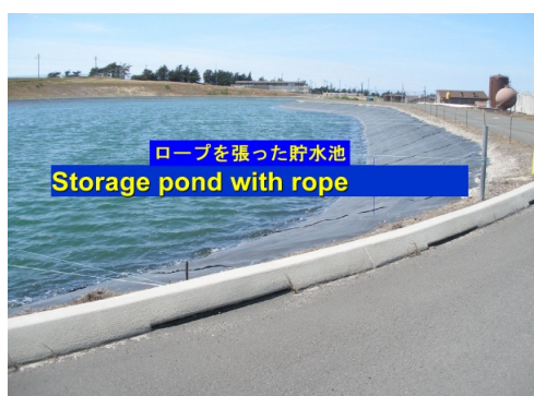
写真1-7-1 モントレー郡の貯水池(野生生物の侵入対策を実施) (オープン形式)
