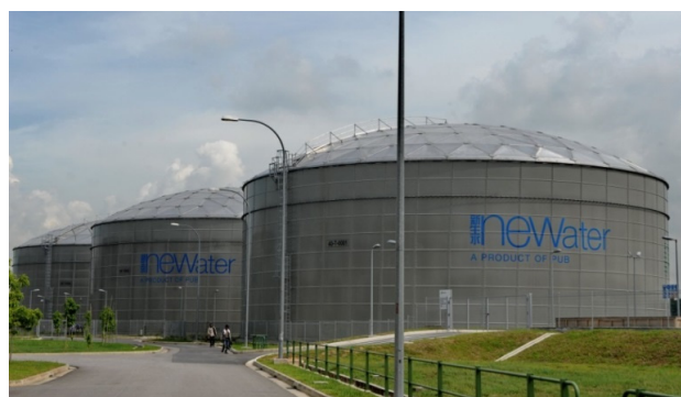
写真1-7-2 シンガポールの再生水貯留タンク (クローズ形式)
